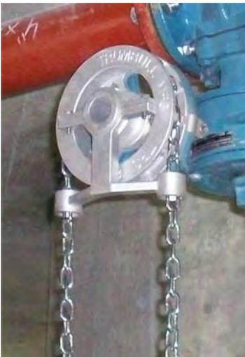
**EDELSTAHL-KETTENRÄDER VON TRUMBULL** ermöglichen die Betätigung von Armaturenhandrädern in unzugänglichen Höhen durch leichten Zug an der Kette. Dank ihrem Universaldesign können die Kettenräder am Handrad montiert oder direkt an der Armaturenschindel verstiftet werden.
